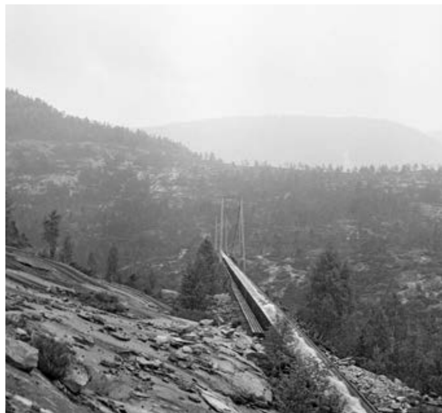
Brua som førte tømmerrenna (Dynerrenna) over Fyresåna (Digitalt Museum)
